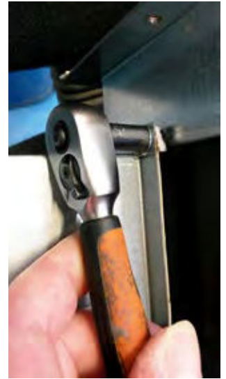
1.12 Refit fan outlet (if fitted) to fan
